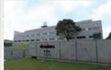
フェーズドアレイ気象レーダを設置した日清紡研究所
