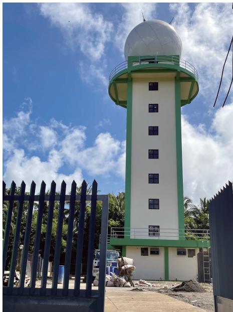
レーダ塔外観（サマル島）
