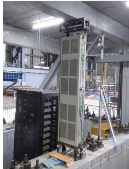
1階 サーバラック, 多重無線通信装置
