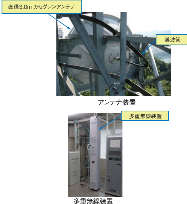
図2 多重無線装置（標準的な構成）
