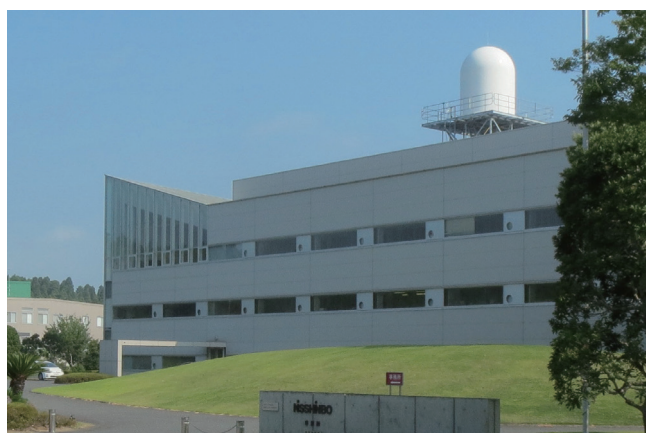
図5 千葉市内に設置したフェーズドアレイ気象レーダー Fig.5 Phased array weather radar installed in Chiba city
