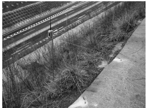
図5 のり面への施工例 (JCU-920)
