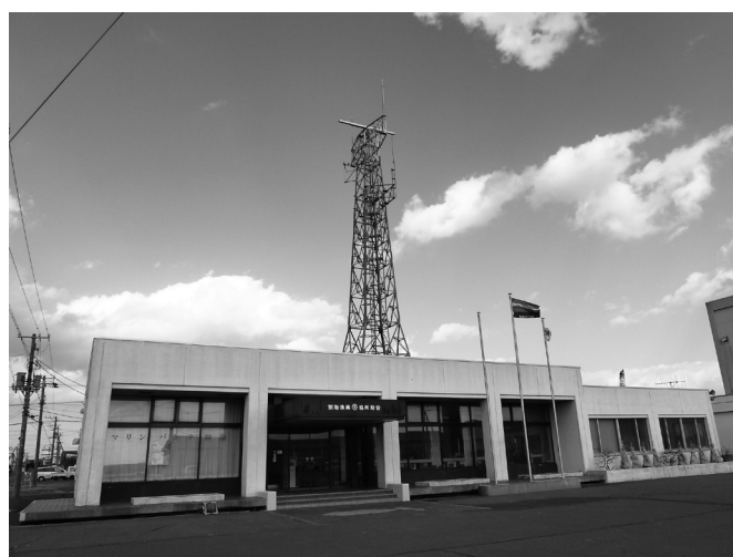
空中線 (漁協屋上) Radar Antenna (Top of the tower)
