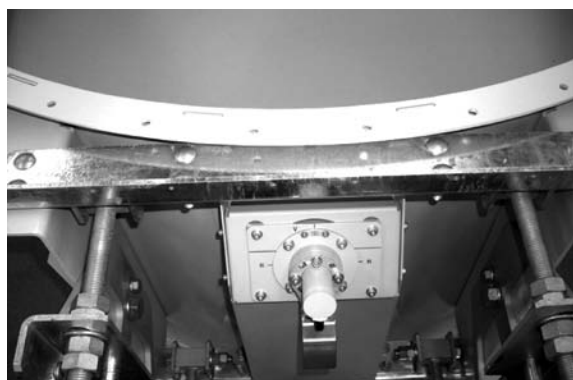
図8 一次放射器の組込み
