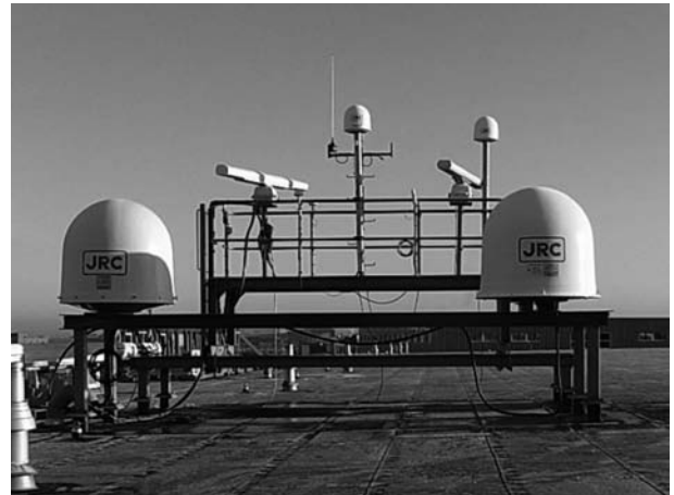
図3 アムステルダム支店屋上の船上装置設置状況
