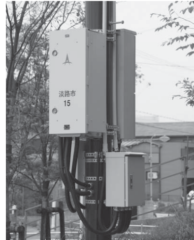
図4 画像伝送機能付き屋外拡声子局 (右下のボックスが画像伝送装置)
